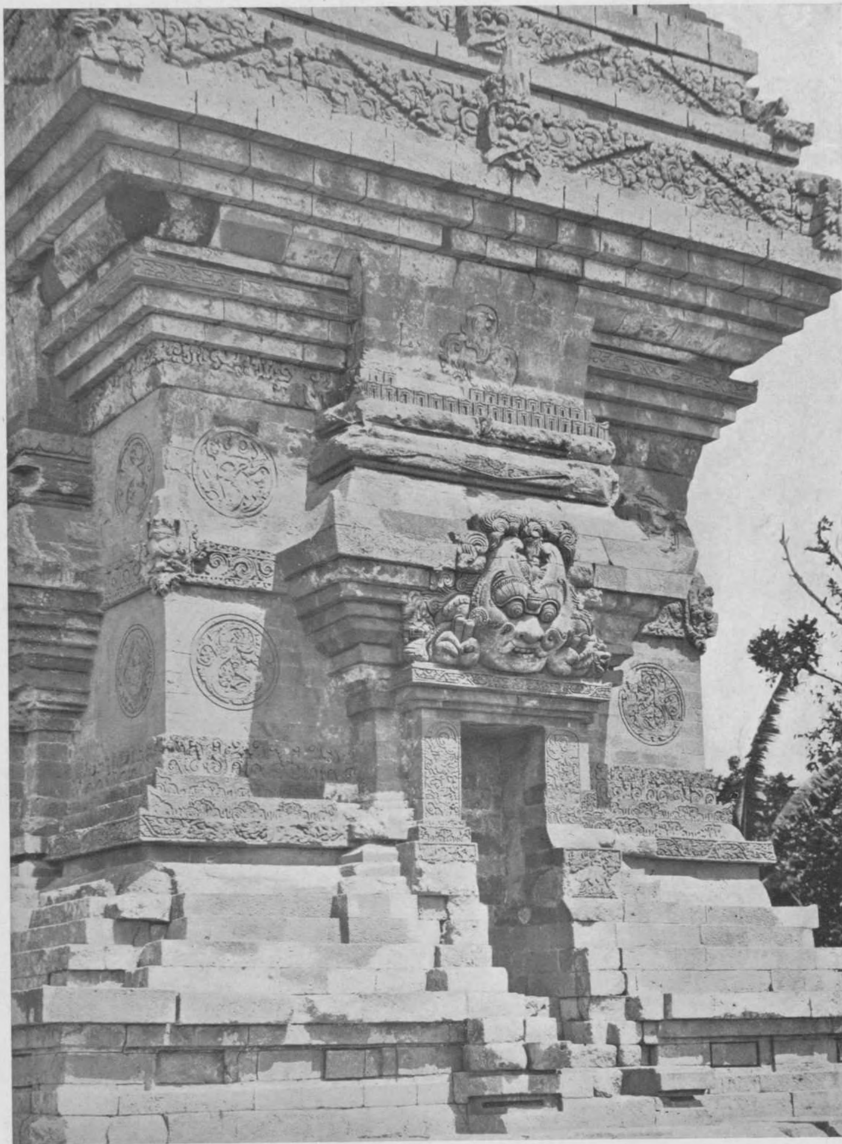
Plaat 4. Tjandi Kidai. Detail Oostgevel.
