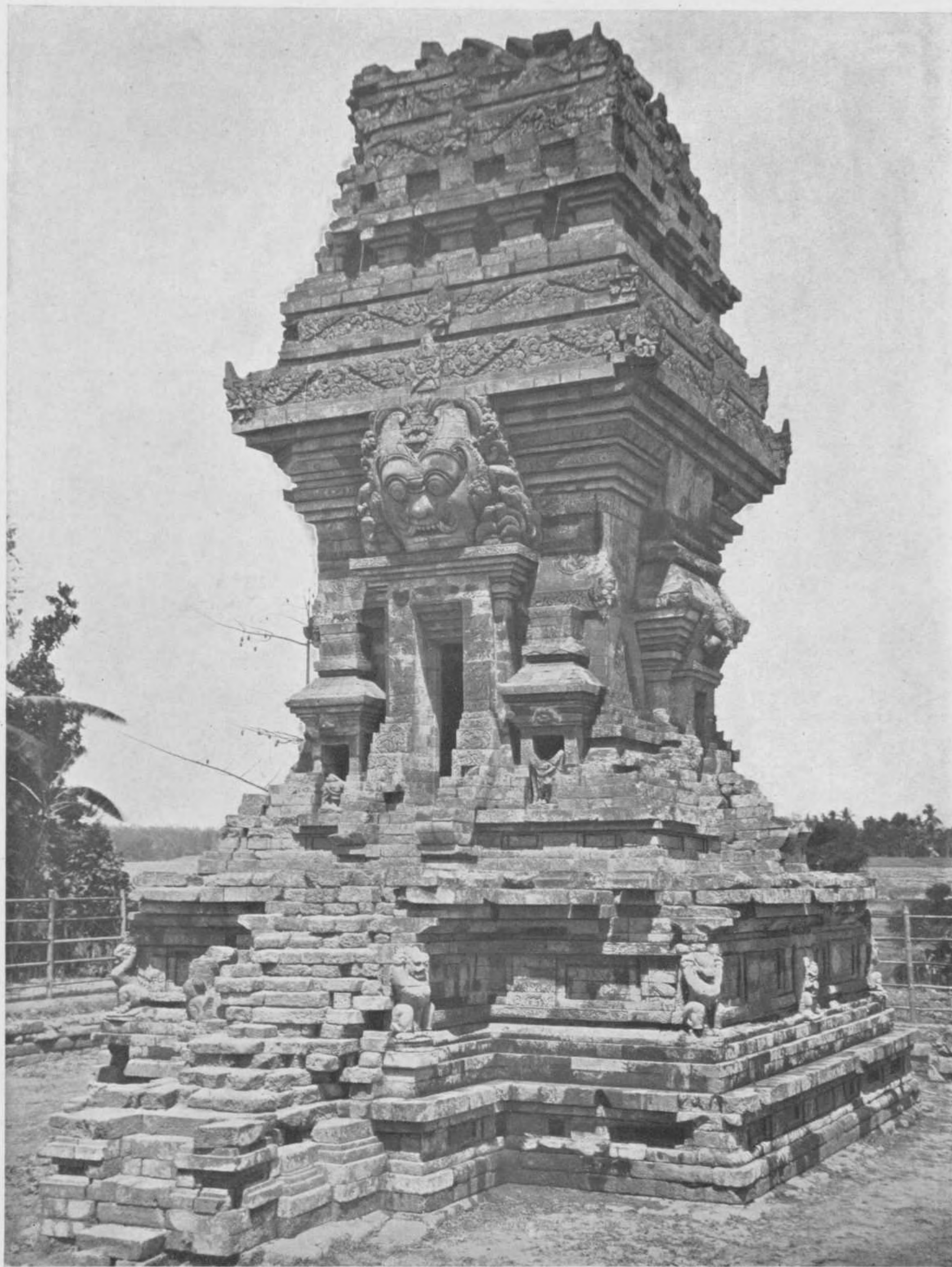
Plaat 1. Tjandi Kidul. Westgevel.
